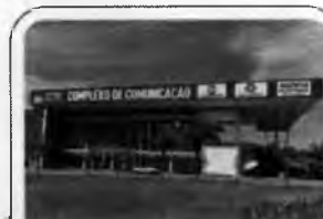
FACHADAS EM ACM LETRAS EM INOX PVC EXPANDIDO
